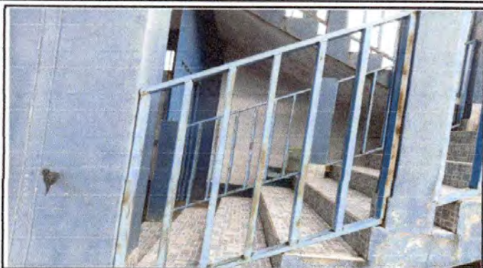
Foto1: Reparación de barandas
