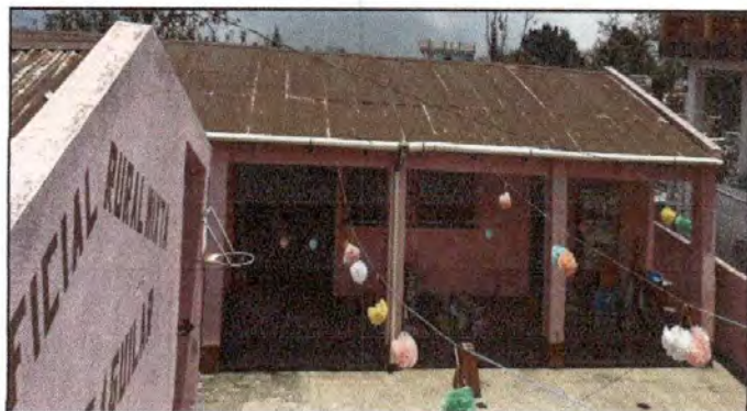
Foto 4: Laminas deterioradas
